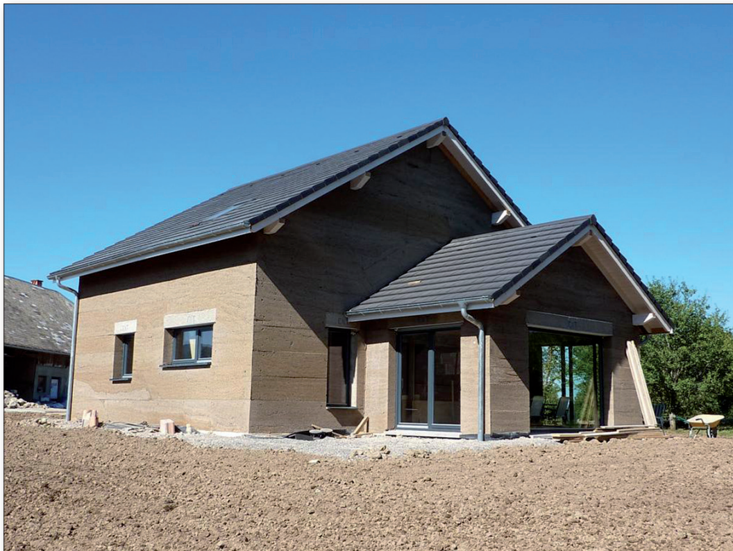
Fertiggestellter Rohbau eines ökologischen Hauses aus Hanfbeton
