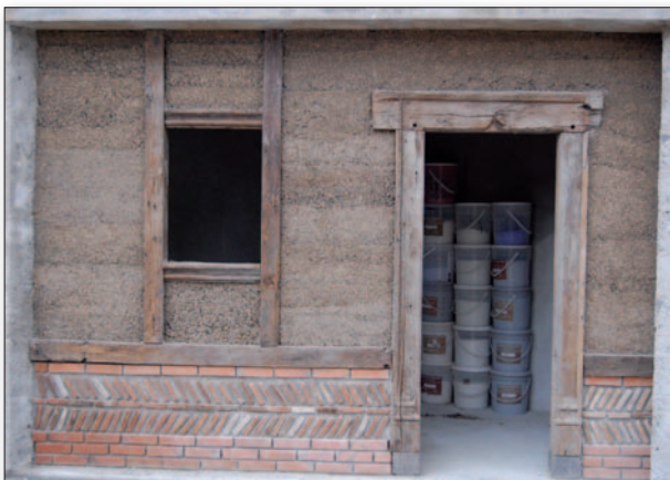
Ausmauern von altem und neuem Holzfachwerk
