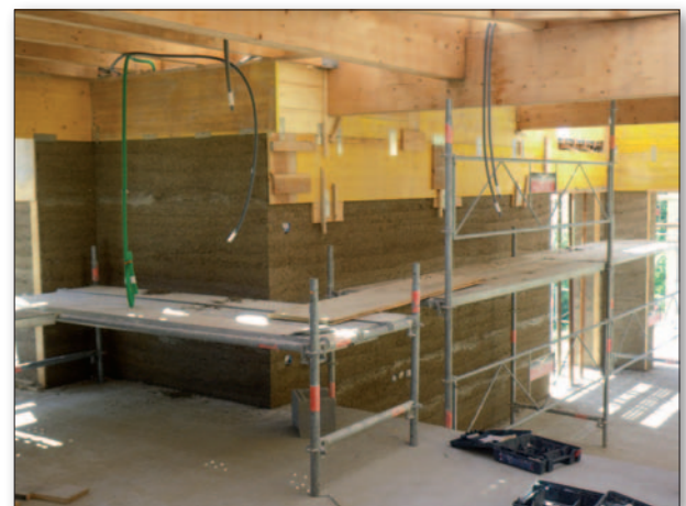
eingebracht und dabei an der Schalungswandung und um die Stützbalken zusätzlich verdichtet.
