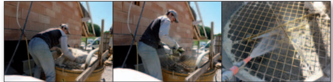
Anmischen des Hanfbeton
