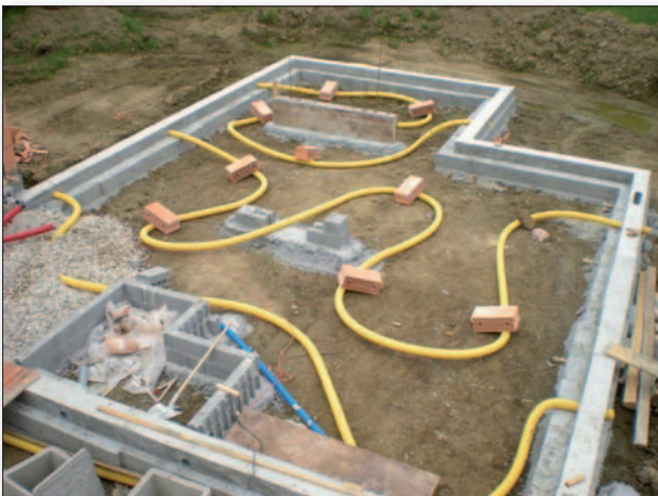
Drainage und Bodenplatte
