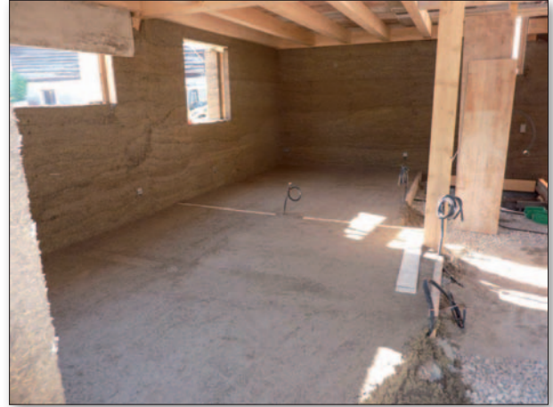
Bodenplatte Einbringen der ca. 20 cm starken Bodenplatte aus Hanfbeton
