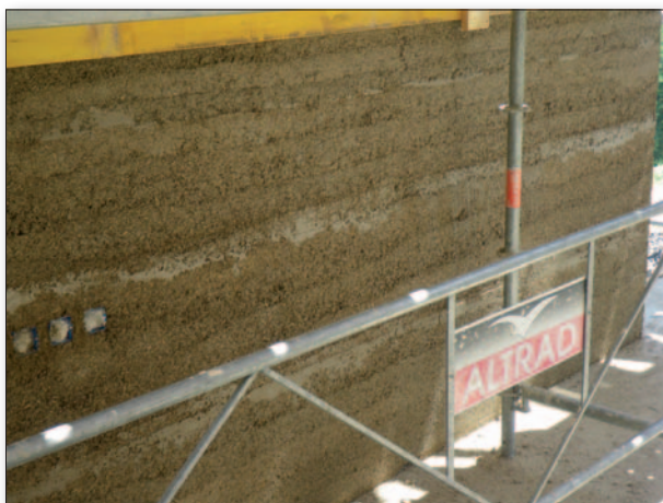
Aufbau der Hanfbetonwände Die Wandstärke beträgt 40 cm. Der Hanfbeton wird in Schichten von ca. 15 cm in die Gleitschalung
