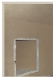
Decorative coating - Entreprise Intérieur Chanvre (71).
