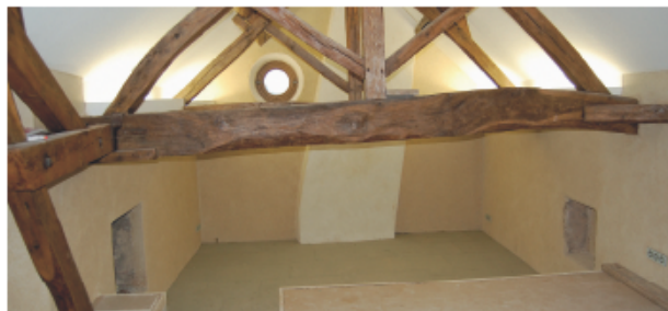
Decorative coating - Entreprise Intérieur Chanvre (71).
