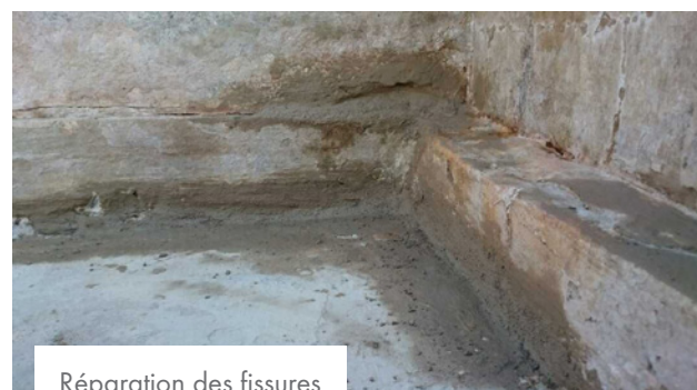
Réparation des fissures
