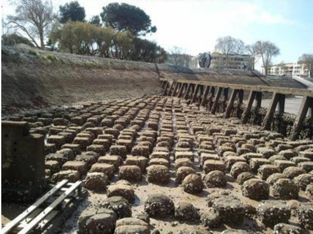
Foto di lavori in mare 2011
